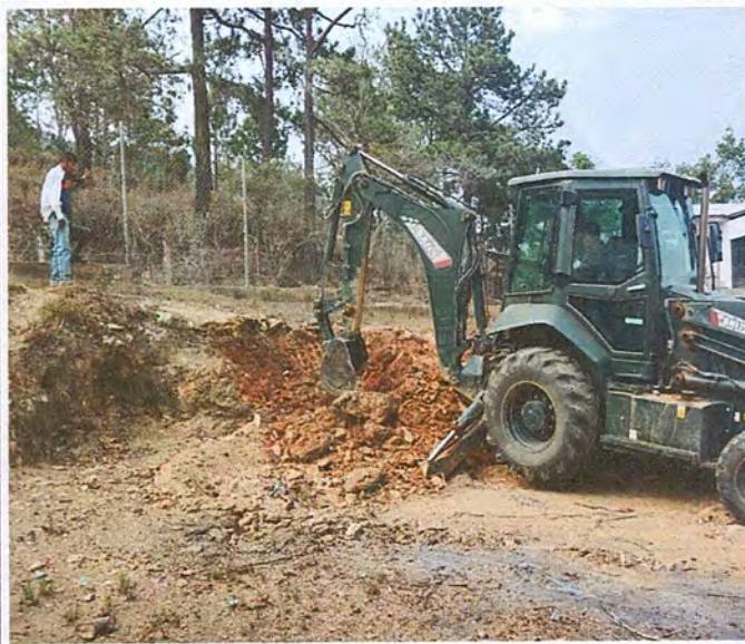
Foto 2: Aquí se inician los trabajos para que el piso rocoso quede plano.
