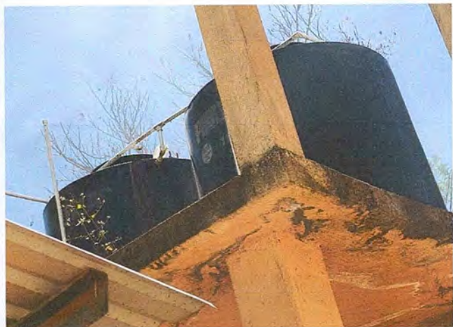
Foto 3: Tinacos en mal estado, mejorar la conexión de agua potable y terraza necesita ser reforzada para un mejor soporte de los tinacos.
